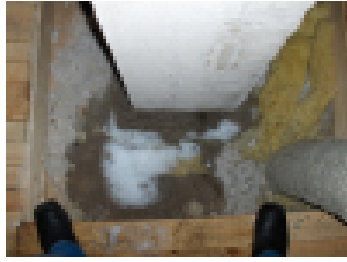
Pyrylunta yläpohjan päällä hormin vieressä.
