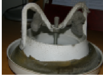
Puhdista likaiset poistoilmaventtiilit kaksi kertaa vuodessa.
