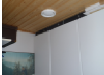
Vaatehuoneen poistoilmaventtiili.
