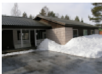
Lumi ja taloa kohti kallistuva maanpinta kastelevat taloa.
