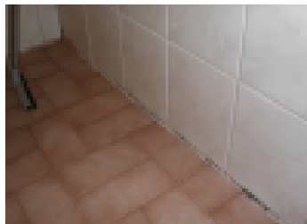
Pilkut laattasaumoissa viittaavat riittämättömään ilmanvaihtoon.
