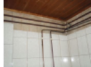
Vanhaa muovitapettia ei saa jättää laatoituksen alle.
