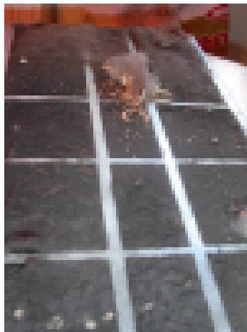
Varmasti vaihtokunnossa oleva ilmanvaihtokoneen suodatin.
