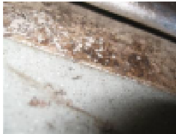
Liitos ei ole pitänyt, levy mikrobien peitossa
