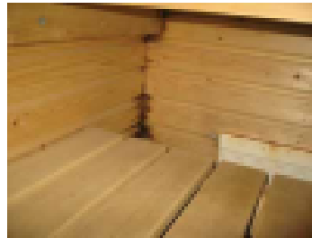
Liiallinen kastelu voi lahottaa seinät nopeasti
