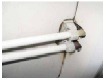
Putkien läpivienti suihkutilassa
