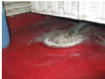
Puhdista lattiakaivo säännöllisesti
