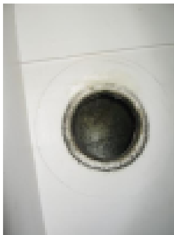
Putkistot tarkatetaan ja venttiilit puhdistetaan
