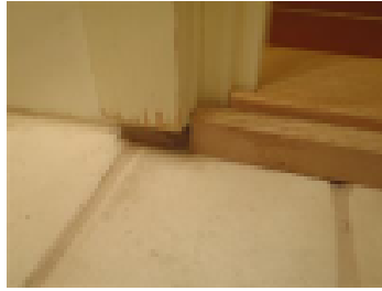
Väärän tyyppinen ja liian matala kynnyks
