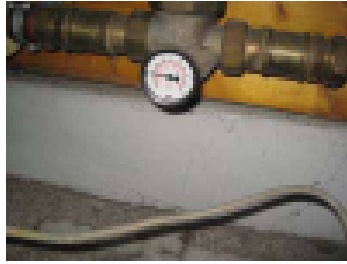
Painemittari käyttövedessä
