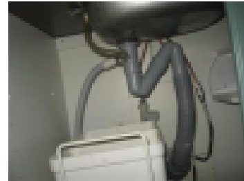
Poistoputki pitää olla mekaanisesti kiinnitetty kalusteisiin
