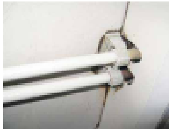
Putkiläpiviennit tarkastettava
