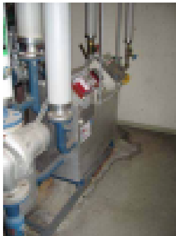
Lämmönvaihtimenvuotojalkia
