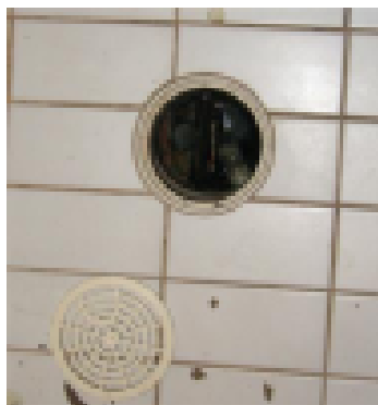
Kaivojen liittymät takratetaan
