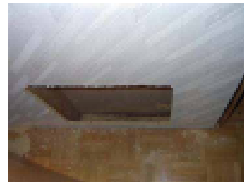
Seinän avaus kuivalta puolen
