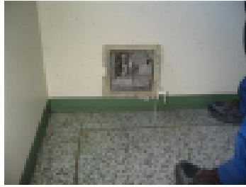
Kanaalien luukut tiivistetään
