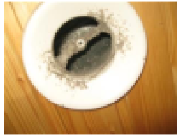
likaiset venttiilit ja kanavistot puhdistetaan
