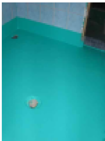
Uusi vedeneriste odottaa laatoittamista
