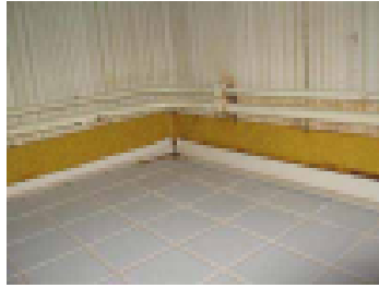
Muovimatton päälle laatoitettu
