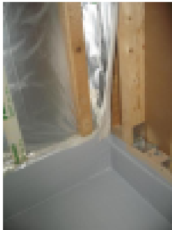
höyrysulku tulee liittää vedeneristeeseen huolellisesti
