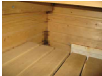
Liiallinen kastelu voi lahottaa seinät nopeasti
