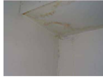
Putkista tiivistyy kosteutta
