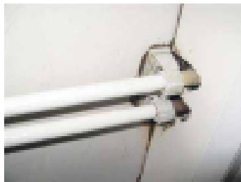
Putkien läpivienti suihkutilassa
