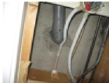
Läpiviennit tulee tarkastaa avaamalla alaslaskuja
