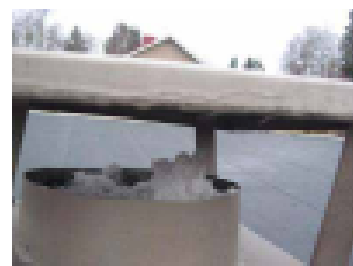
Poistoilma tukittu katolla
