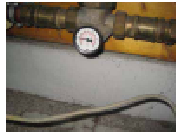
Painemittari käyttövedessä
