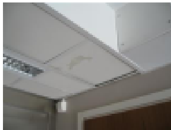
Avataan tarkastusluukkuja ja koteloida
