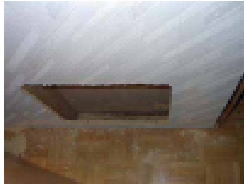
Seinän avaus kuivalta puolen
