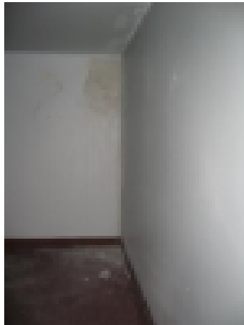
Tilojen piiloon jäävätkin osat on syytä tarkastaa ajoittain
