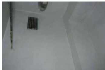
Poistoilmaventtiili
