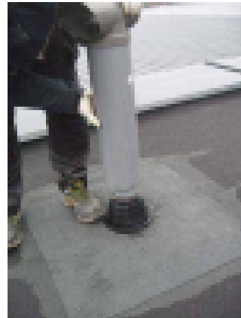
Viemärin tuuletuksen juuritiiviste
