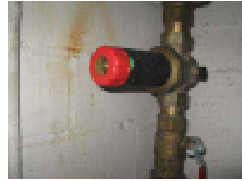
Paineen säätöventtiilit
