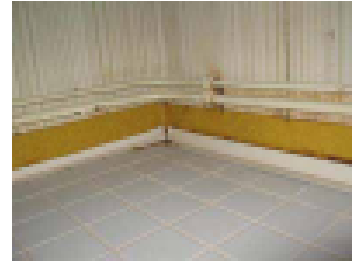
Muovimaton päälle laatoitettu
