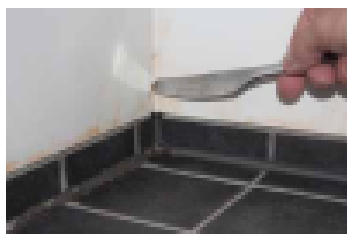
Kylpyhuoneen saumojen tarkastus
