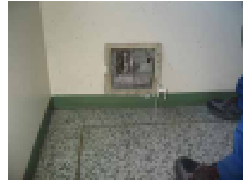
Tarkastusluukujen paikat vaihtelevat
