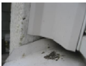
Viistosade on pidettävä aina mielessä, vesi liikkuu ylösikin
