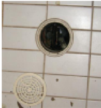
Kaivojen liittymät takratetaan
