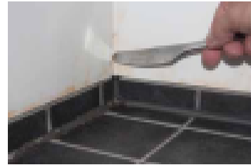
Kylpyhuoneen saumojen tarkastus
