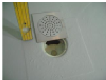
Vedeneriste asennetaan kokotilaan, seinille myös
