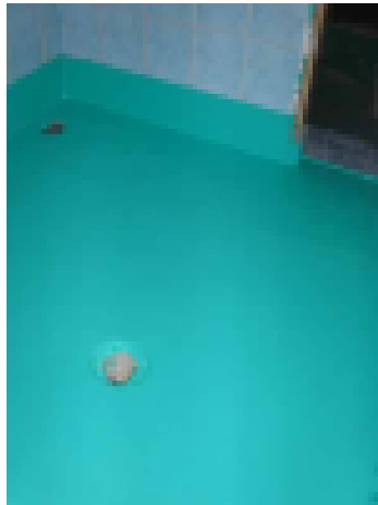
Uusi vedeneriste odottaa laatoittamista
