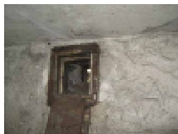
Venttiilit kiinni ja kanavat likaiset
