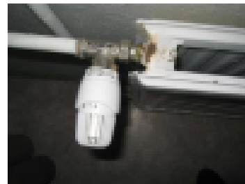
Patterit kestävät kauemmin, kunhan niiden kuntoa seurataan
