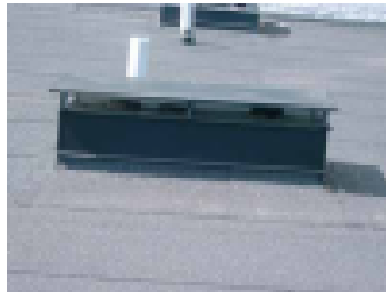
Sadekatos ilmanvaihtohormien päällä
