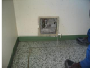
Kanaalien luukut tiivistetään
