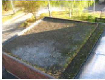
Vahvistettu alue lumien pudotusta vastaan
