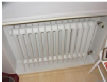
Patteriventtiilit ja termostaatit ikääntyvät 10 vuodessa
