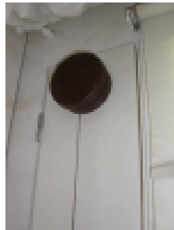
Korvausilmaventtiili on helppo asentaa puiseen tuuletusluukkuun
