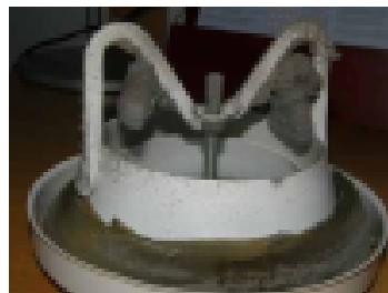
Likaiset poistoilmaventtiilit tulee puhdistaa kaksi kertaa vuodessa
