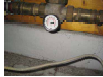
Painemittari käyttövedessä
