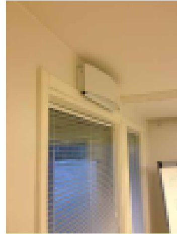
Korvausilman sekoitinventtiili auttaa vedontunteen vähentämisessä
