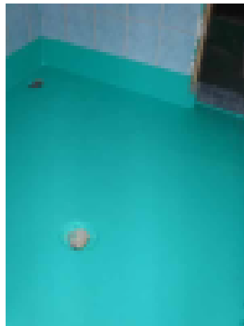
Uusi vedeneriste odottaa laatoittamista
