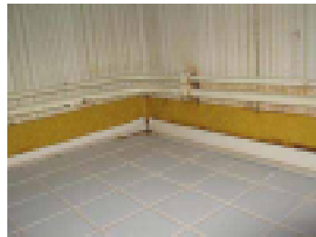
Muovimaton päälle laatoitettu
