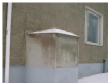
väestönsuojan pakotunnelin pää
