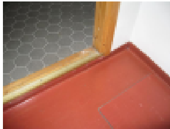
Saumojen tiiveyttä ja liittymiä seurataan
