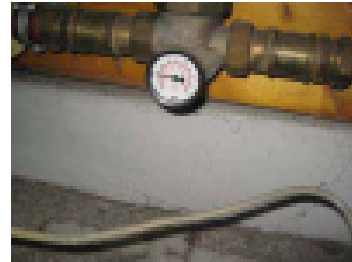
Painemittari käyttövedessä
