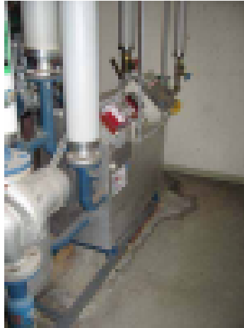
Lämmönvaihtimenvuotojalkiä
