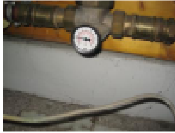
Painemittari säätimen yhteydessä
