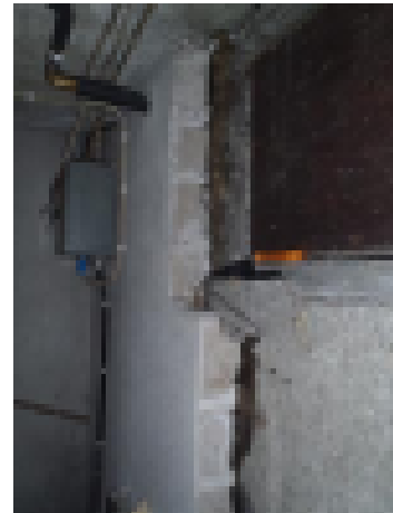
Kaksoismuuri on usein erittäin märkä ja aina poistettava
