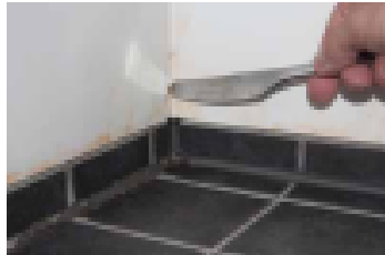
Kylpyhuoneen saumojen tarkastus
