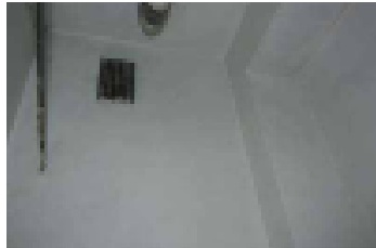
Poistoilmaventtiili
