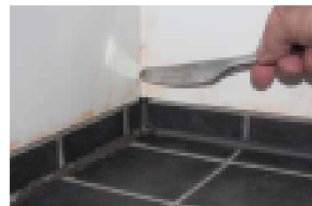
Kylpyhuoneen saumojen tarkastus
