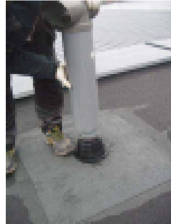
Viemärin tuuletuksen juuritiiviste
