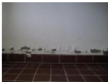
Kosteus ilmenee usein värimuutoksina, ilman mittauksiakin
