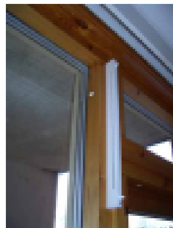
Yhden karmiventtiilin kautta saatava ilmavirta on suhteellisen vähäinen, mutta tilanne on silti parempi kuin ilman venttiilejä
