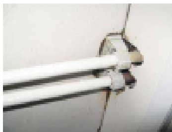
Putkiläpiviennit tarkastettava
