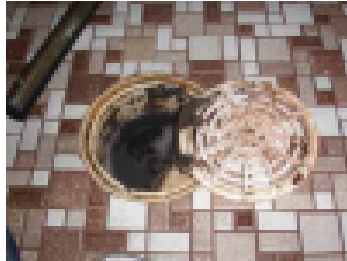
Lattiakaivot tulee puhdistaa säännöllisesti
