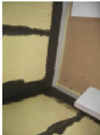
Saumät vedeneristetään ja tasoitetaan
