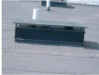
Sadekatos ilmanvaihtohormien päällä
