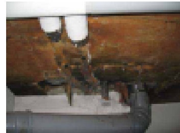
Tiivistymää putkistoissa
