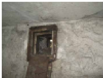
Venttiilit kiinni ja kanavat likaiset
