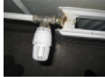
Patterit kestävät kauemmin, kunhan niiden kuntoa seurataan
