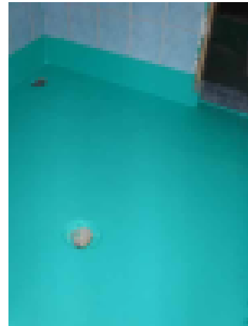
Uusi vedeneriste odottaa laatoittamista
