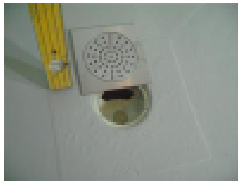
Vedeneriste asennetaan kokotilaan, seinille myös
