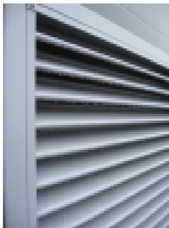
Säleikkö on jäässä, pystysäleikkö on parempi
