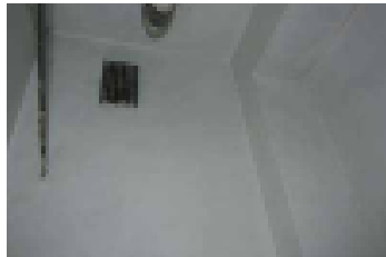
Poistoilmaventtiili
