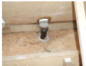
Viemäreitä tarkkaillaan kotelossa ja kuvataan
