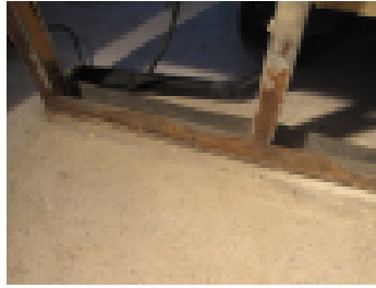
Laatoituksen takana on oltava tiheä runko
