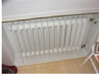
Patteriventtiilit ja termostaatit ikääntyvät 10 vuodessa
