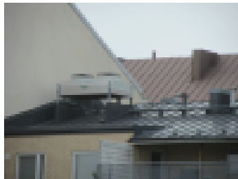
Telineet suunnitellaan kattotyypin mukaisesti erillisenä asiantuntijan toimesta
