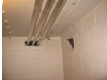
Venttiilit ja ilmareitit on pidettävä avoimina suunnitelmien mukaan
