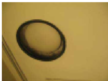
Venttiili kätkeyty rakenteisiin
