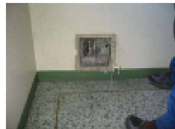
Patteriverkostontarkastusluukku
