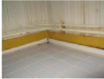
Muovimaton päälle laatoitettu
