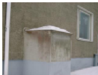
väestösuojan pakotunnelin pää
