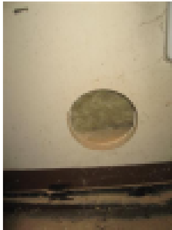
Poraus märkätilan ulkopuolelta
