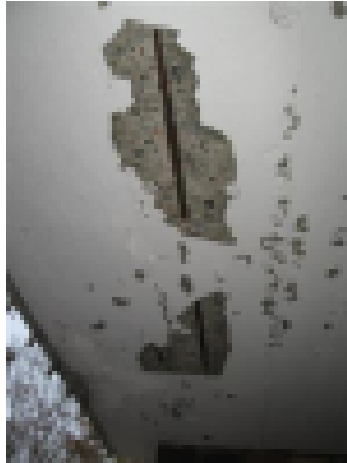
Teräksset jo näkyvissä
