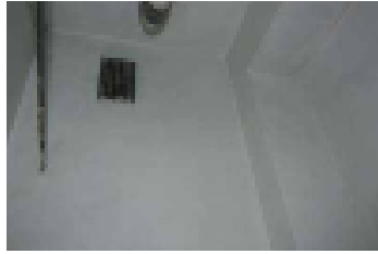
Poistoilmaventtiili
