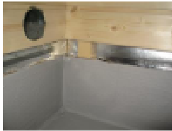
Panealien takana on oltava tuuletusrako ylös asti
