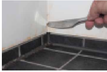
Kylpyhuoneen saumojen tarkastus
