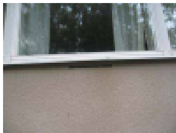
Rakovenntiili ikkunan alla
