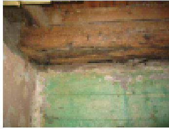
Kellarinseinä liittyy hirsirakenteeseen
