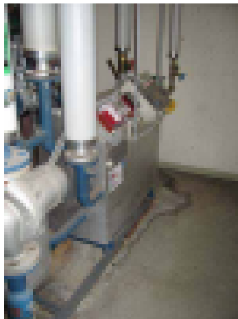
Lämmönvaihtimenvuotojälkiä
