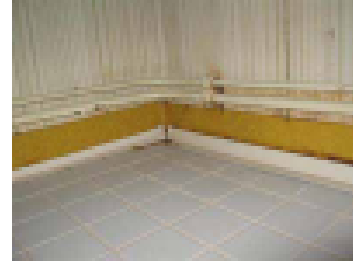
Muovimaton päälle laatoitettu
