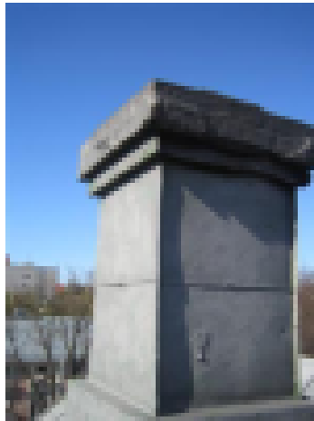
Piiput ja rakenteiden läpiviennit
