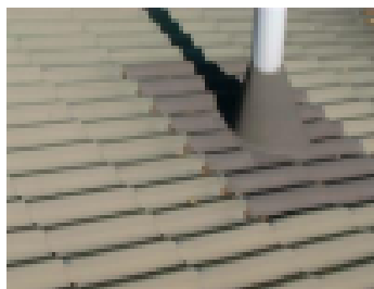
Tarkasta piippujen juuret ja läpivienit
