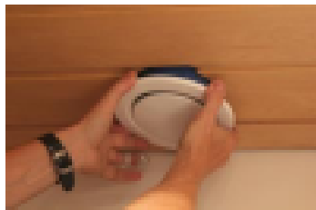
Venttiilin irroitus puhdistukseen kaluksesta kiertämällä
