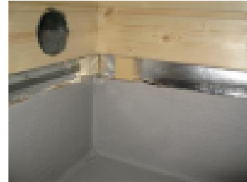
Suora reikä ulos tuo kylmää talvella ja jäädyttää lattiaa, siksi turhia lattialämmityksiä
