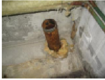
Putkien läpiviennit tiivistetään kaasutiiviisti
