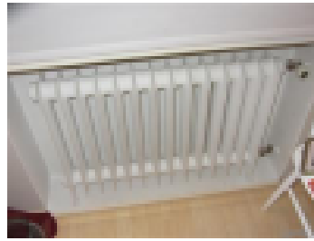
Patteriventtiilit ja termostaatit ikääntyvät 10 vuodessa
