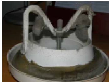
Likaiset poistoilmaventtiilit tulee puhdistaa kaksi kertaa vuodessa
