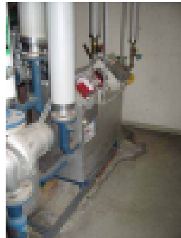
Lämmönvaihtimenvuotojälkiä
