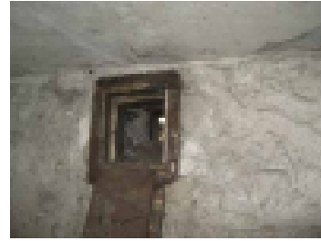
Venttiilit kiinni ja kanavat likaiset
