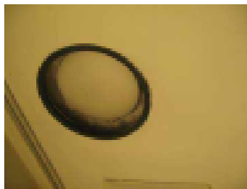
Venttiili kätkeyty rakenteisiin
