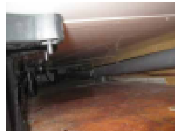
Viemäri kalusteen sokkelissa
