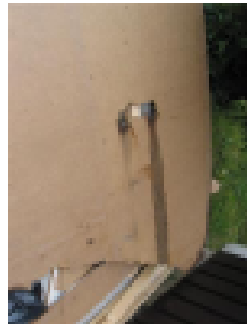
Tiivistymisen jälkeä levyä takana
