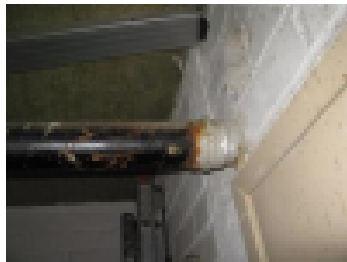
Putket vanhenevat, käyttöikä täyttyy
