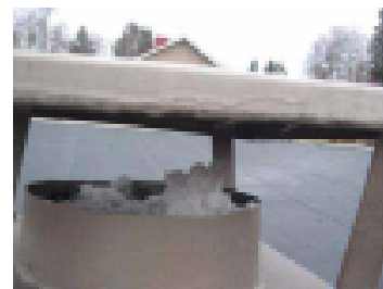
Poistoilma tukittu katolla
