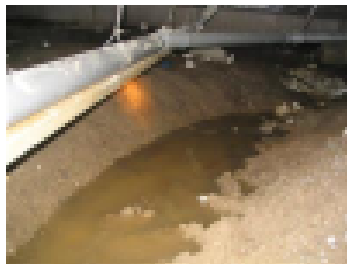
Kannakkeet on oltava ruostumattomia. tila kuivattava
