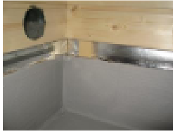
Panelien takana on oltava tuuletusrako ylös asti
