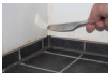
Kylpyhuoneen saumojen tarkastus
