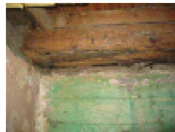
Kellarin seinä liittyy hirsirakenteeseen
