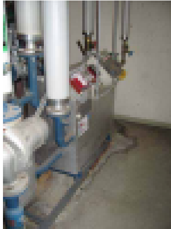
Lämmönvaihtimenvuotojälkiä
