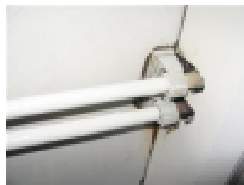
Putkiläpiviennit suihkunurkassa
