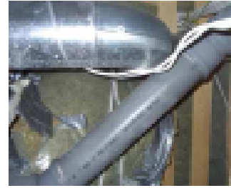
Viemärit risteilevät kotelokatossa
