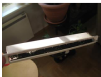
Korvausilmaventtiilin suodatin pestään
