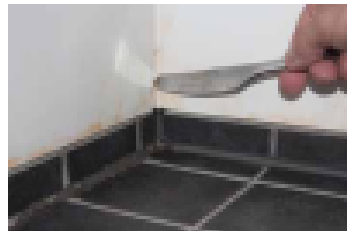
Kylpyhuoneen saumojen tarkastus
