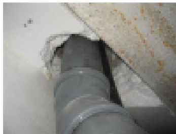
Viemärien tarkastus alapohjassa
