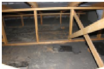
Kosteuneen kohdan tutkimukset
