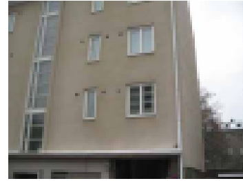
Seinäventtiilit näkyvät usein vain julkisivussa, sisäpuoli on tukittu
