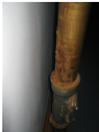
silmäillä viemärit ja liitokset
