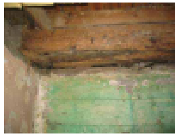
Kellarinseinä liittyy hirsirakenteeseen
