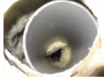
Putken vierestä ilmaa rakenteisiin
