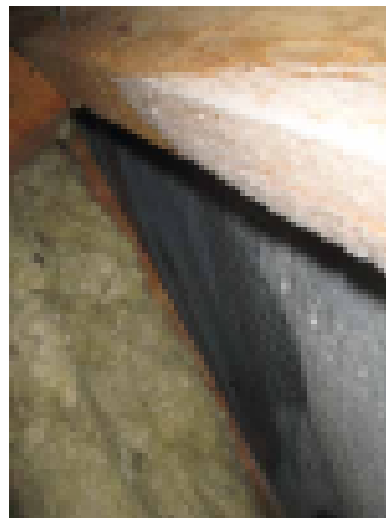
Tuuletustilassa on huono tuuletus ja aluskate jäätyy
