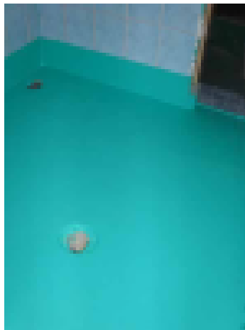
Uusi vedeneriste odottaa laatoittamista
