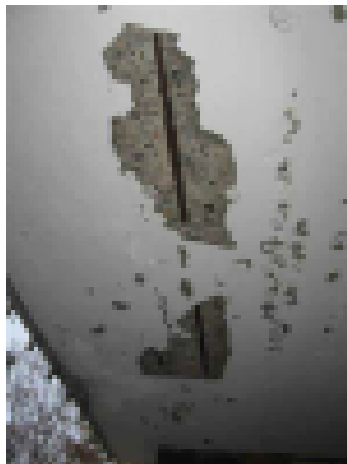
Parvekelaatan alapinnan teräs
