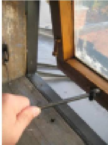
Ikkunoista voidaan tehdä lisätuuletusväyliä
