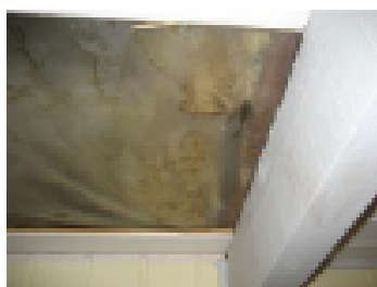
Eristeet kellarin seinän sisäpuolelta poistetaan
