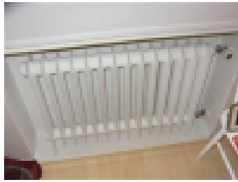
Patteriventtiilit ja termostaatit ikääntyvät 10 vuodessa
