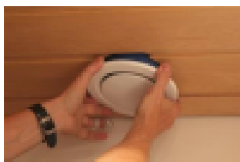
Venttiili avataan pyörittämällä kehystä vastapäivään
