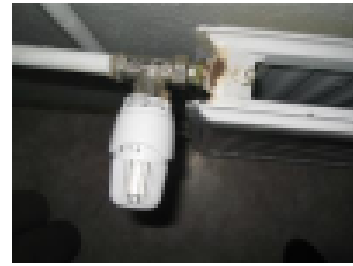
Patterit kestävät kauemmin, kunhan niiden kuntoa seurataan
