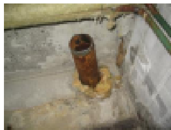
Putkien läpiviennit tiivistetään kaasutiiviisti
