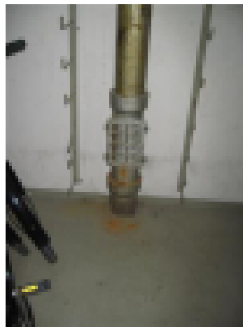
Putkistota tehdään kuvaukset ennen isomman remontin alkua
