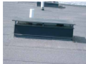
Sadekatos ilmanvaihtohormien päällä
