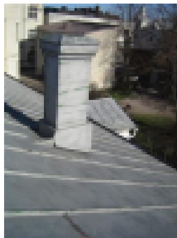
Hyvin tehty pellitys ja tiivistys kestävä satoja vuosia
