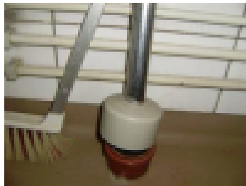
Viemäriliitokset hajulähteinä
