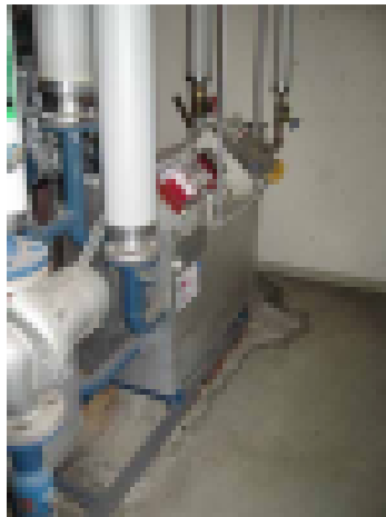
Lämmönvaihdin vuotanut
