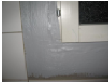
Hyvin tiivistetty karminrako ja seinän vedeneristys
