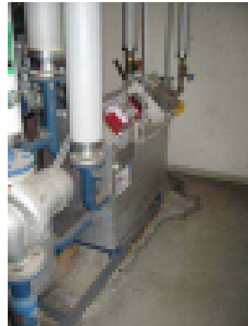
Lämmönvaihtimenvuotojälkiä
