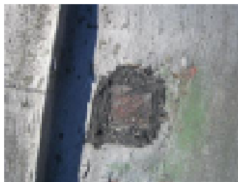
irronneet kiinnikkeet paikattu huonosti
