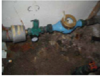
Vuotavia putkiliitoksia
