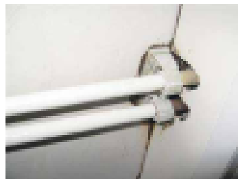
Putkien läpivienti suihkutilassa
