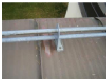
Lumiesteiden kiinnitykset
