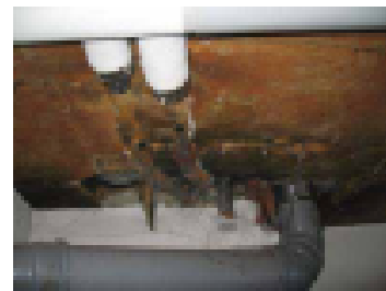
Tiivistymää putkistoissa
