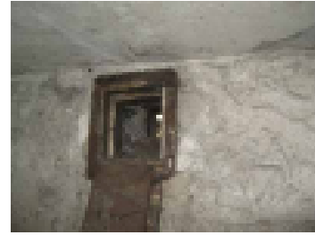
Venttiilit kiinni ja kanavat likaiset
