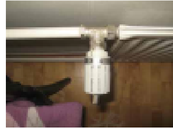
Termostaatit ja venttiilit vanhenevat 10 vuodessa
