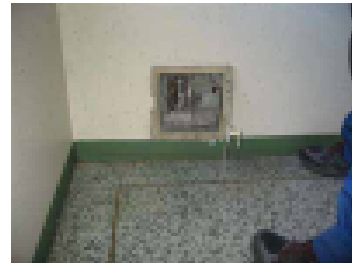
Patteriverkostontarkastusluukku
