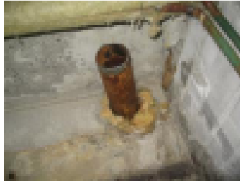
Läpiviennit tiivistetään
