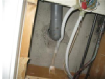
Tarkastusluukut on yleensä merkattu
