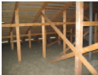
Avonainen räystääs. Tuuli vähentää eristeen toimivuutta
