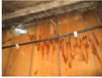
Vinolapteen tuuletus tukittu
