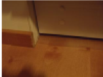
Viotoallas laitteiden alla, myös jääkaapin alla
