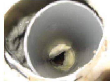
Putken vierestä ilmaa rakenteisiin
