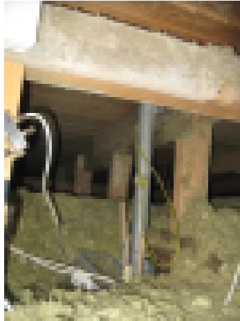
Antenniläpivienti on kosteuslähde aina
