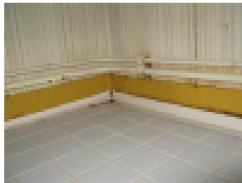
Laatoitettu maton päälle
