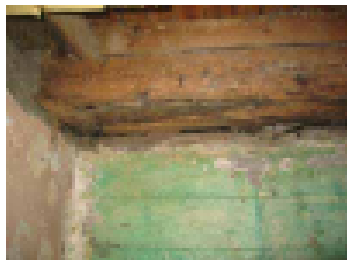
Kellarinseinä liittyy hirsirakenteeseen
