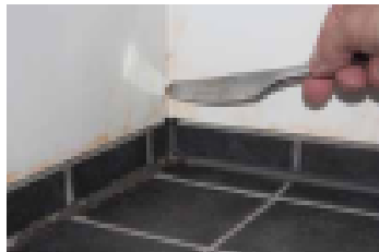
Kylpyhuoneen saumojen tarkastus
