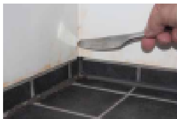
Kylpyhuoneen saumojen tarkastus
