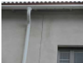
Uusittu katon sadevesijärjestelmä
