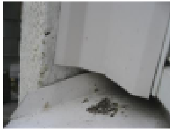
Pellitysten tiiveys pitää huoltaa
