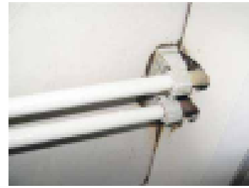
Putkiläpiviennit tarkastettava
