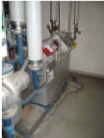
Lämmönvaihtimenvuotojälkiä
