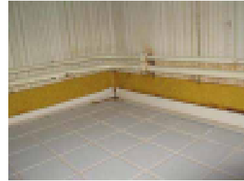
Muovimaton päälle laatoitettu
