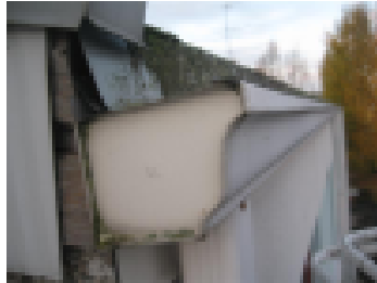
Kourun asema pitää tarkastaa ja kourun kaadot
