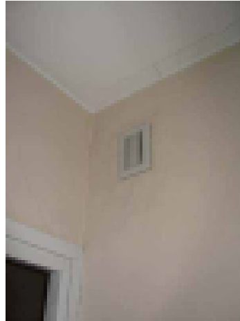
Rakoventtiili seinässä
