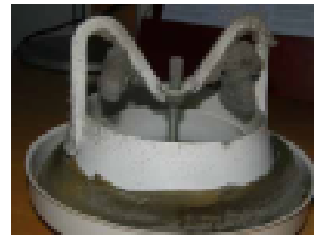
Likaiset poistoilmaventtiilit tulee puhdistaa kaksi kertaa vuodessa
