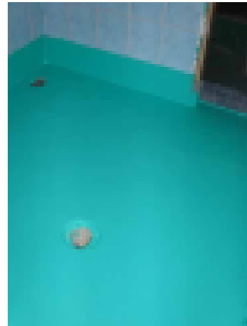
Uusi vedeneriste odottaa laatoittamista
