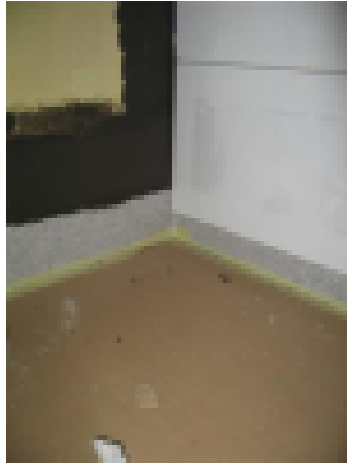
Vedeneristys tehdään kauttaaltaan koko märkätilaan
