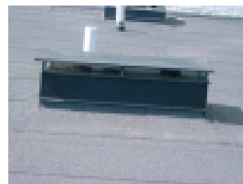
Sadekatos ilmanvaihtohormien päällä
