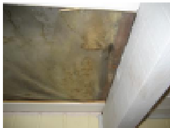
Eristeet kellarin seinän sisäpuolelta poistetaan
