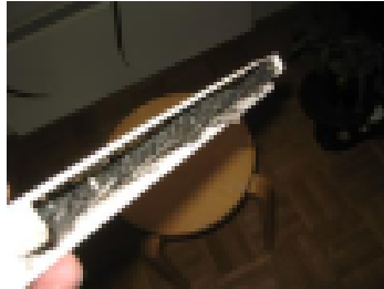
Korvausilmasuodatin ikkunan yhteydessä
