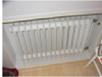
Patteriventtiilit ja termostaatit ikääntyvät 10 vuodessa
