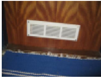
Jälkiasennettu siirtoilmasäleikkö ovessa
