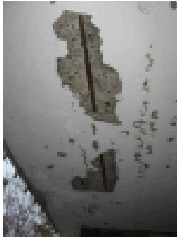
Parvekelaatan alapinnan teräs
