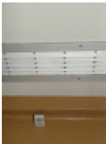
Jos märkätilan kynnyks on tiivis, tulee esim. ovesa olla siirtoilmasäleikkö
