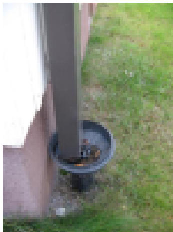
Sadevedet ohjataan omiin kaivoihinsa
