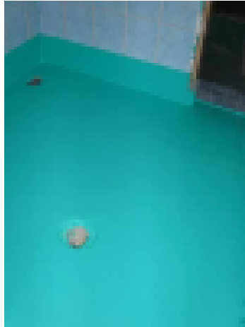
Uusi vedeneriste odottaa laatoittamista
