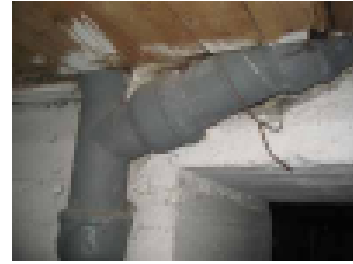
Viemariliitos alapohjatilassa
