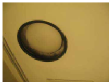
Venttiili kätkeyty rakenteisiin
