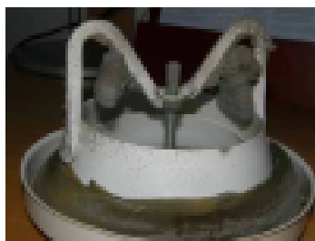
Likaiset poistoilmaventtiilit tulee puhdistaa kaksi kertaa vuodessa
