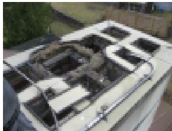
Savupiippu vaatii sadehatun. Öljypoltin syö sementtiliiliä nopeasti
