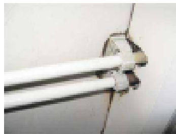
Putkien läpivienti suihkutilassa
