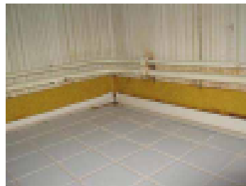
Muovimaton päälle laatoitettu
