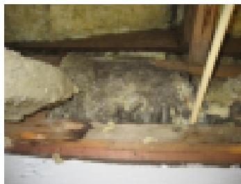
Harvat läpiviennit hengittävät kosteutta yläpohjaan
