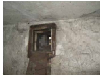
Venttiilit kiinni ja kanavat likaiset
