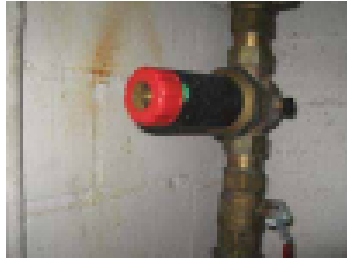
Paineen säätöventtiilit
