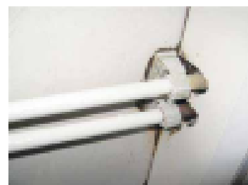
Putkiläpiviennit tarkastettava
