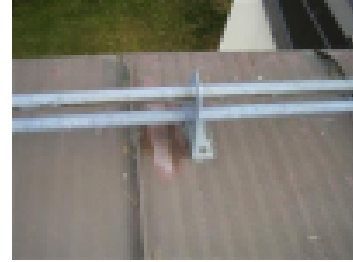
Lumiesteet on tarkastettava keväisin
