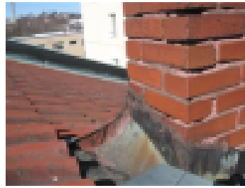
Tarkasta piippujen juuret ja läpivienit
