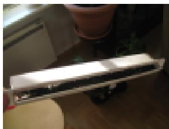
Korvausilmaventtiilin suodatin pestään
