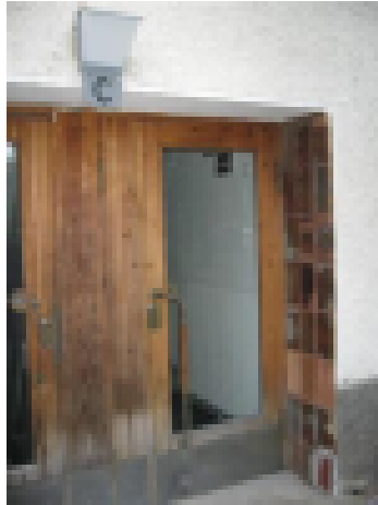
Sisääntulon sadesuojaus on tärkeää
