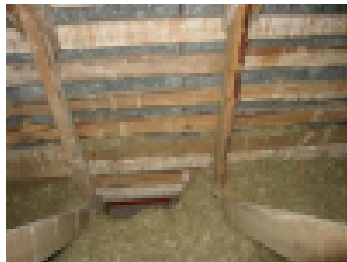
Aluskate on vettäpitävä osa levytiili- ja peltikatossa
