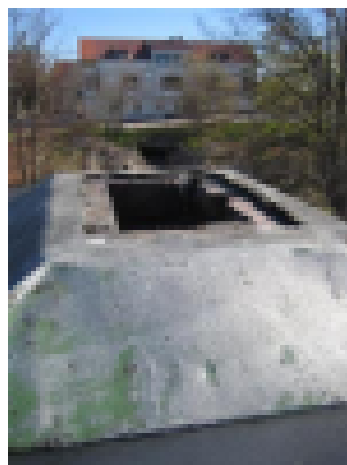
Suojapellititys toimii näinkin, kun piippu jatkuvasti käytössä!
