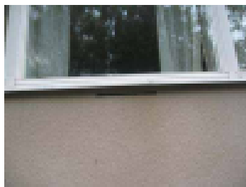
Rakoventtiili ikkunan alla
