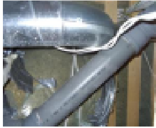
Yläpohjassa tarkastetaan putkien lämpöeristys
