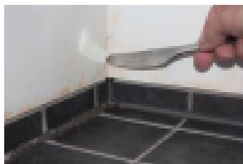
Kylpyhuoneen saumojen tarkastus
