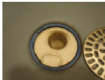
Kaivo ja sen sisäosa
