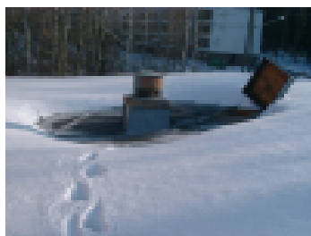
Huippuimuri sulattaa lumen katolta
