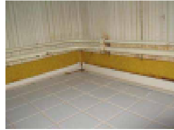
Muovimaton päälle laatoitettu
