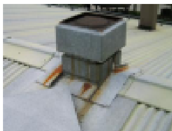
Läpivientien juurien tarkastus. Usein onistuu parhaiten alapuolelta
