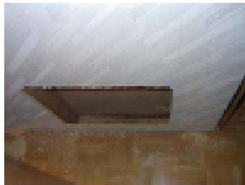
Seinän avaus kuivalta puolen
