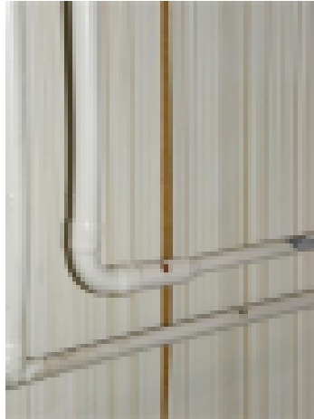
Auenneet tapetin saumat ja liitokset eivät pidä vettä
