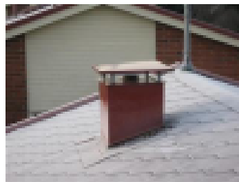
Piipuissa on hyvä olla sadehattu suojaamassa
