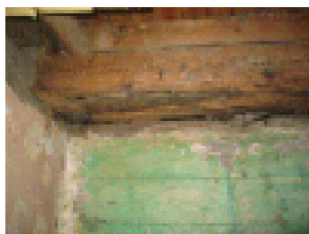
Kellarin seinä liittyy hirsirakenteeseen
