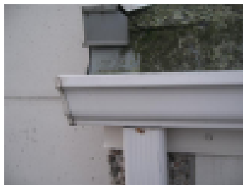
Räystäskourun aseman tarkastaminen
