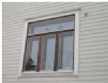
Ikkunoita on huollettava säännöllisesti
