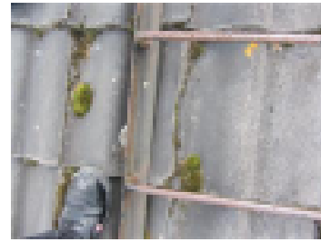
Lapetikkaan kiinnikkeiden läpiviennit
