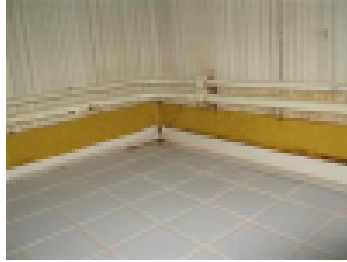
Laatoitettu maton päälle
