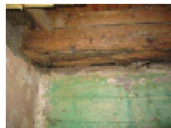
Kellarin seinä liittyi hirsirakenteeseen
