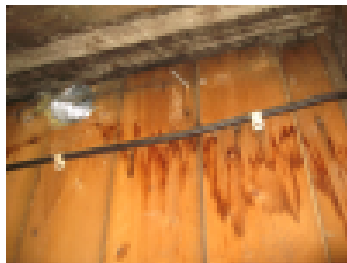
Tilan tuuletuksen puutteet ilmenevät mikrobikasvuna. tuuletus pitää huolehtia
