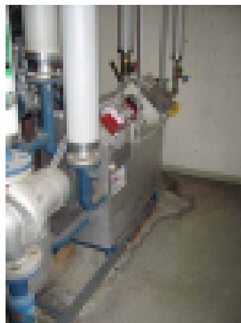
Lämmönvaihtimenvuotojälkiä
