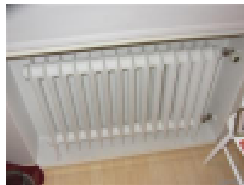
Patteriventtiilit ja termostaatit ikääntyvät 10 vuodessa
