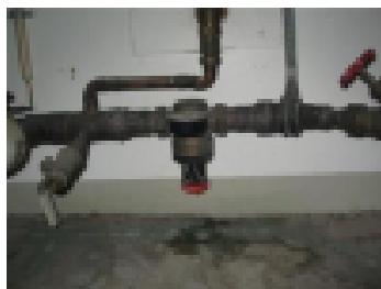
Vanhat korjatut vuotojäljet pitää poistaa
