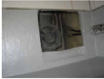
Sopivan kokoinen tarkastusluukku
