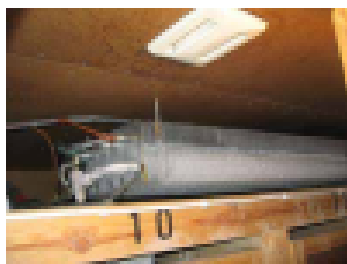
Kylmäkellarin jäähdytyspatteri
