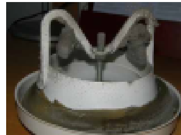
Likaiset poistoilmaventtiilit tulee puhdistaa kaksi kertaa vuodessa
