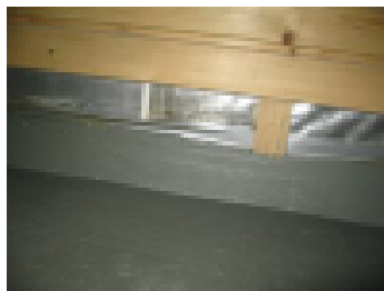
Panelien takana on tuuletusrako
