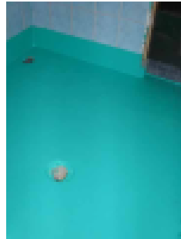
Uusi vedeneriste odottaa laatoittamista
