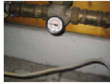
Painemittari käyttövedessä
