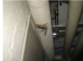
Asbestieristeet rispaantuu
