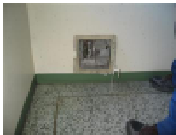
Kanaalien luukut tiivistetään
