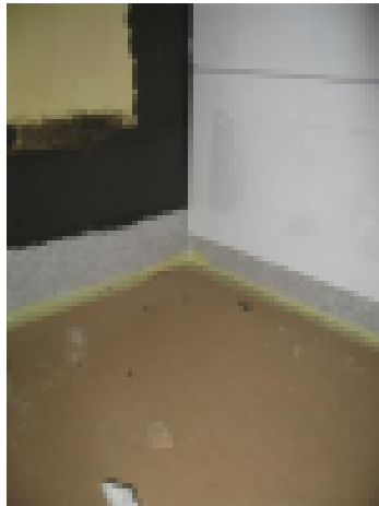
Vedeneristys tehdään kauttaaltaan koko märkätilaan
