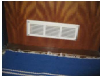
Jälkiasennettu siirtoilmasäleikkö ovessa
