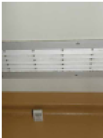
Jos märkätilan kynnyks on tiivis, tulee esim. ovesta olla siirtoilmasäleikkö
