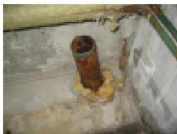
Putkien läpiviennit tiivistetään kaasutiiviisti
