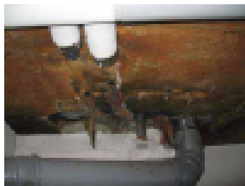
Tiivistymää putkistoissa
