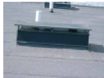
Sadekatos ilmanvaihtohormien päällä
