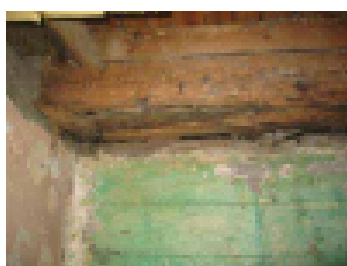
Kellarin seinä liittyy hirsirakenteeseen
