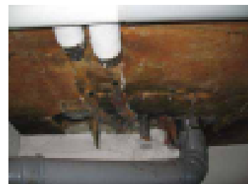
Tiivistymää putkistoissa
