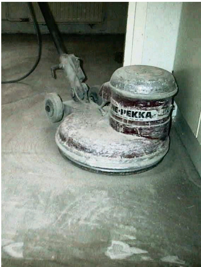
Kuva 2. Vanha liima poistettiin hiomalla.
