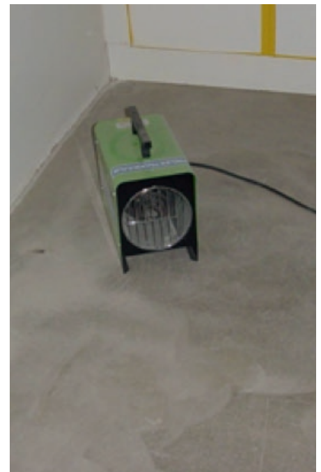
Kuva 3. Asunnon sisälämpötilaa nostettiin sähkölämmittimen avulla.
