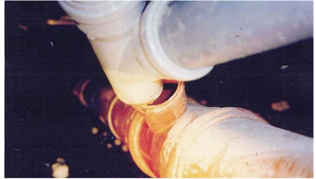
Kuva 13. Kaksoislaatta-alapohjan lämmöneristetyssä on putkivuoto, joka on aiheuttanut runkolaa- tan päältä lähtevässä puurunkoisessa lastulevyvä- liseinässä kosteusvaurion. Vaurion jäljet ovat näh- tävissä seinän pintarakenteessa, kun jalkalista on irrotettu.
