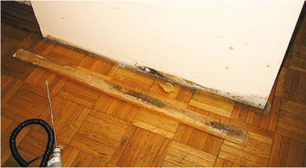
Kuva 13. Kaksoislaatta-alapohjan lämmöneristetyssä on putkivuoto, joka on aiheuttanut runkolaa- tan päältä lähtevässä puurunkoisessa lastulevyvä- liseinässä kosteusvaurion. Vaurion jäljet ovat näh- tävissä seinän pintarakenteessa, kun jalkalista on irrotettu.
