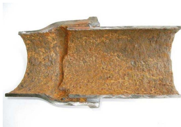
Kuva 49. Riittävän hyväkuntoinen 60-luvun valurautaviemäri, joka voidaan pinnoittaa tai sujuttaa.
