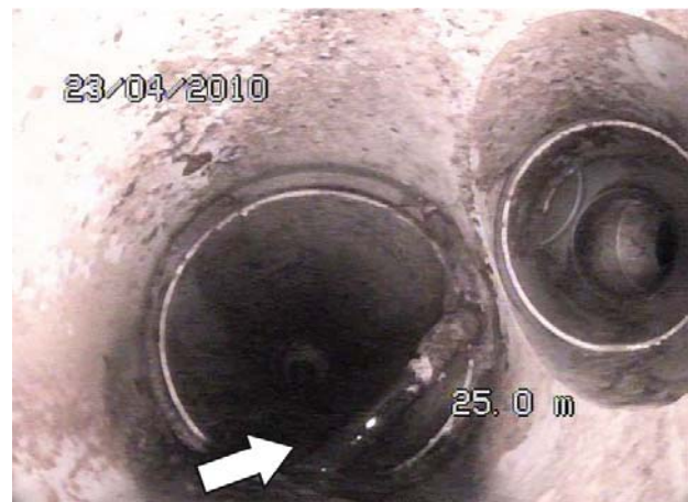
Kuva 32. Kumirengastiivistee on osittain pois paikoiltaan.
