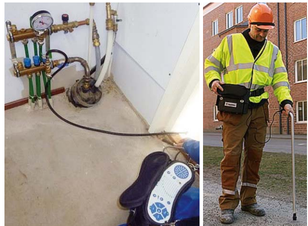
Kuva 29. Laitteet liitetään vuotavaan putkistoon, johon laitetaan "erikoiskaasua".
