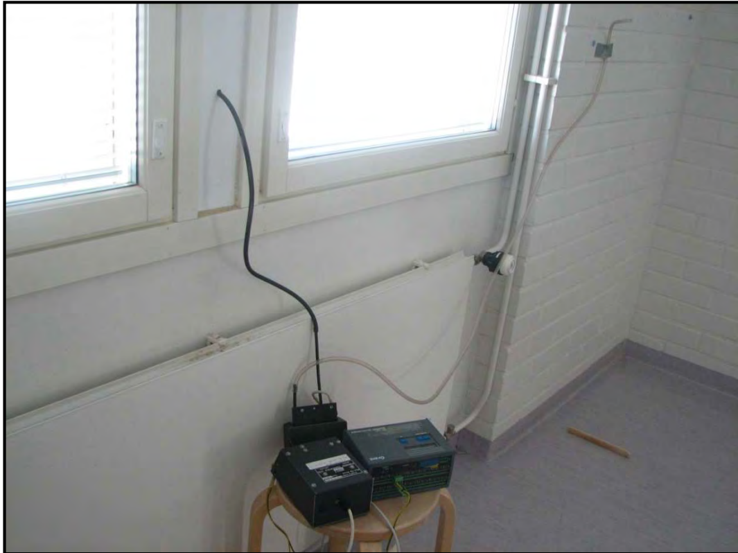
Kuva 35. Paine-eromittaus ulkoseinän yli sijaitsi huoneessa A.
