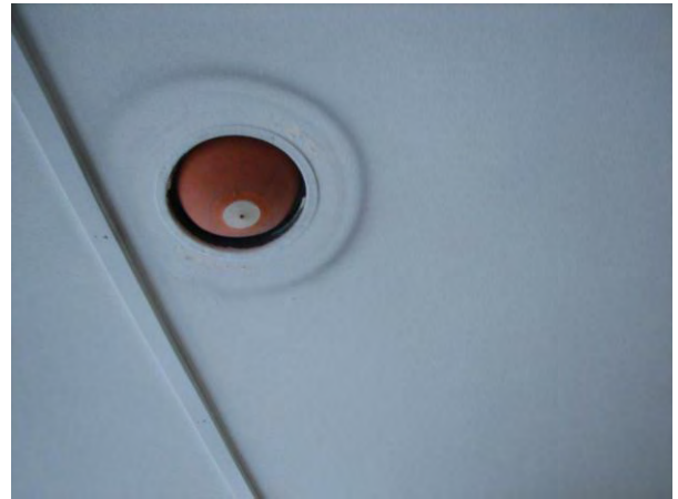
Ilmanvaihtokanavat tiivistettiin pääasiassa pumpattavilla kumipalloilla.
