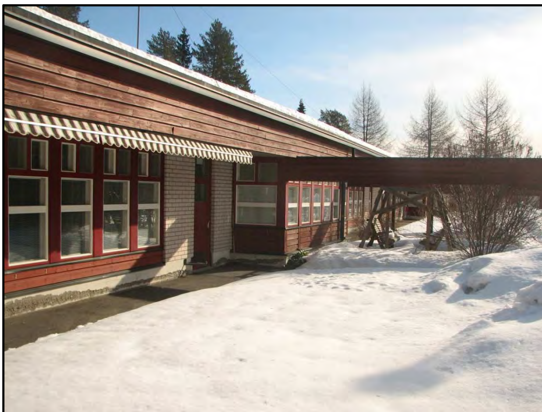
Kuva 25. Palvelurakennuksen yleiskuva etupihan puolelta. Koehuoneisto sijaitsee kuvassa etualalla.
