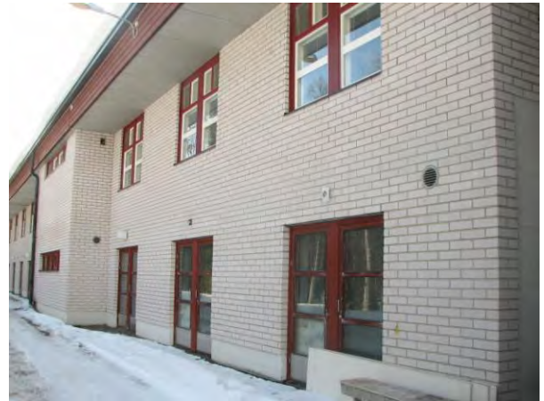
Yleiskuva takapihalta. Kellariin johtavia ovia ja äärimmäisenä oikealla huoneen A ikkuna.
