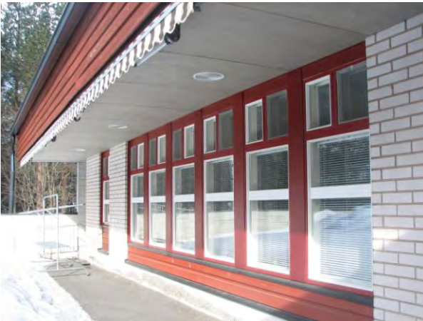
Etupiikan yleiskuva. Kuuden ikkunan takana huone D ja viimeisenä huonone B ikkuna.
