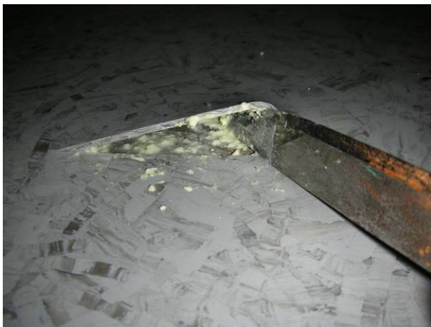
Kuva 21. Saippuoitunut mattoliima.
