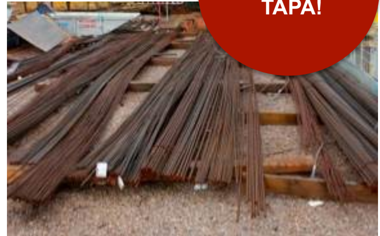
Metallituotteet varastoidaan aluspuiden päälle.
